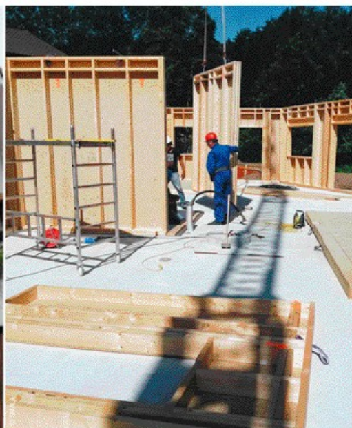
La maison partagée de la Smala a été construite avec des panneaux ossature bois préfabriqués. Les caissons ont ensuite été isolés en laine de bois.
